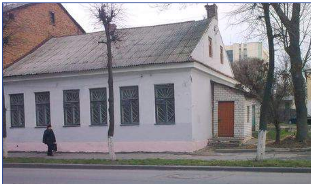
Фото здания до реконструкции...
