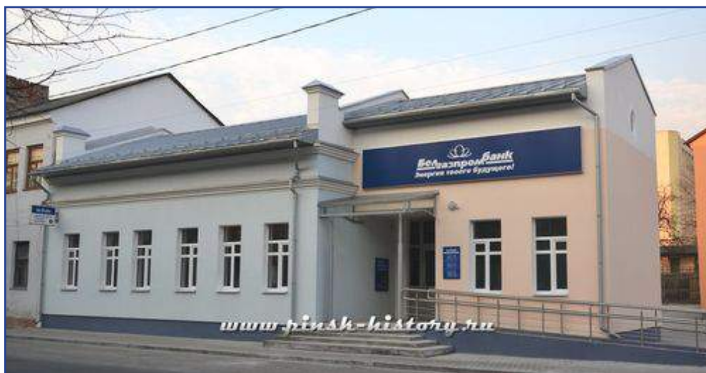
...и после реконструкции
