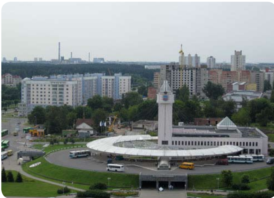
19 июля 2010 года, вид на стройплощадку нового здания головного банка с высоты птичьего полета
