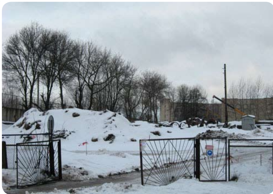
Сейчас на стройплощадке ведутся работы по врезкам магистральных сетей...
