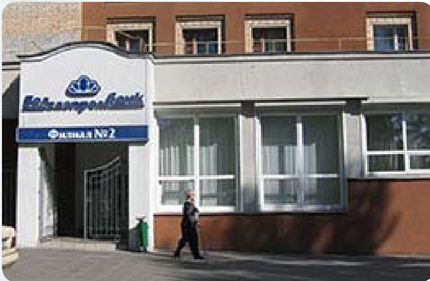
Фасад здания второго филиала
