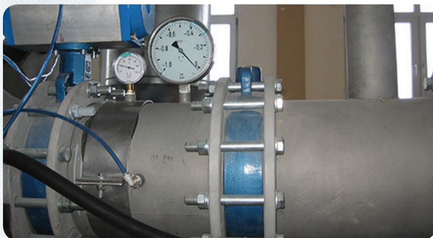
Чтобы удержать воздух под таким давлением, трубы должны быть толстостенными, а гайки прочными.
