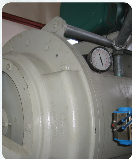
Давление воздуха в рабочей зоне – 4,5 МПа. Это очень много. Отработанный теплый воздух выбрасывается на улицу.
